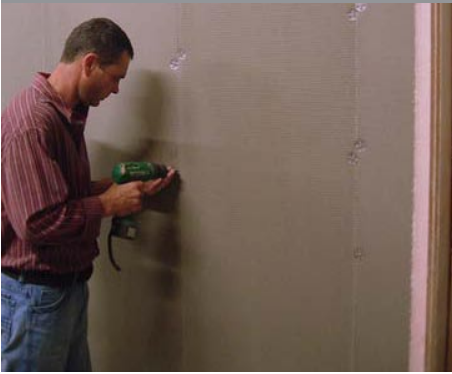
Build Stud Partitions
